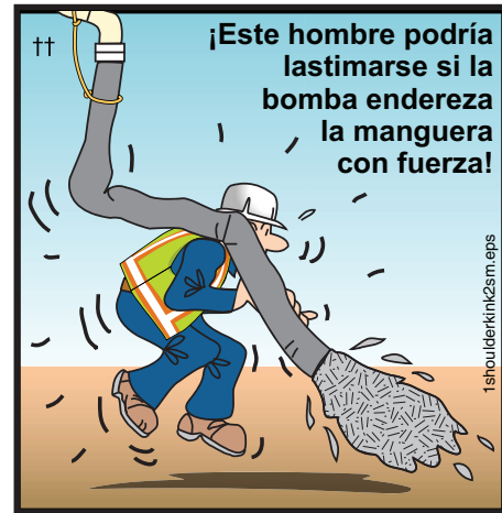
Figura 49 Doblar la manguera crea un peligro
